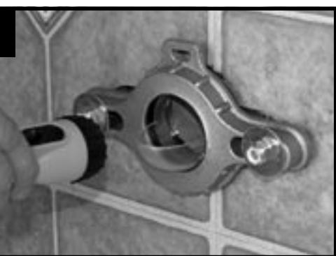
Trancher le calfatage existant et enlever la cuvette à l'aide d'un maillet et d'un couteau à mastic. Démonter les supports, gratter le calfatage et nettoyer le mur.
