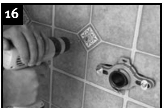
Percer les trous des ancrages du bas de la cuvette et y monter les ancrages de plastique.
